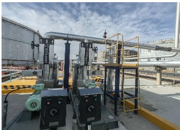
图 3.1 污水输送地上化
