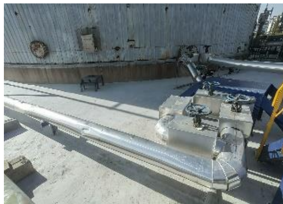
图 3.2 储罐切水管线地上化
