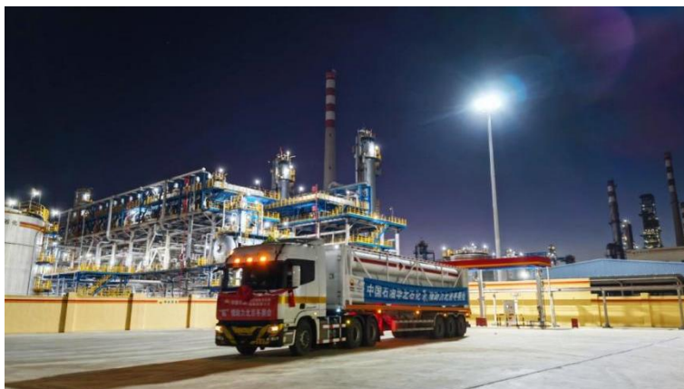
图 2 2000 Nm 3 /h 氢能助力北京冬奥会
