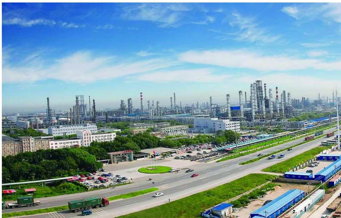
图1 天津石化厂区
