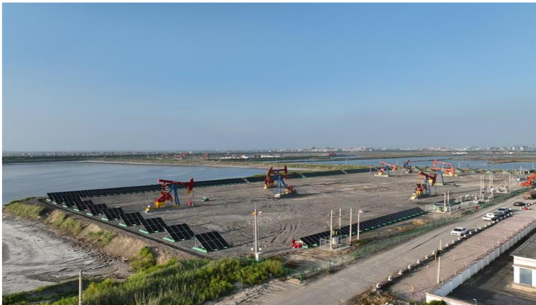
陆上油田作业区 G13 多元微电网平台
