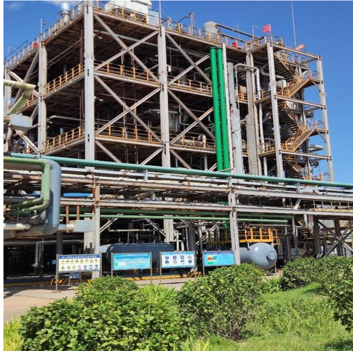
图3 TDI 工艺废渣处理装置
