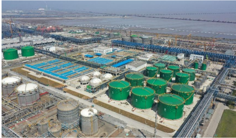
图3 镇海炼化“大污水处理场”
