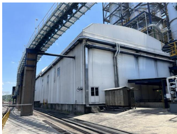
图3 金陵石化 III 焦化密闭除焦设施
