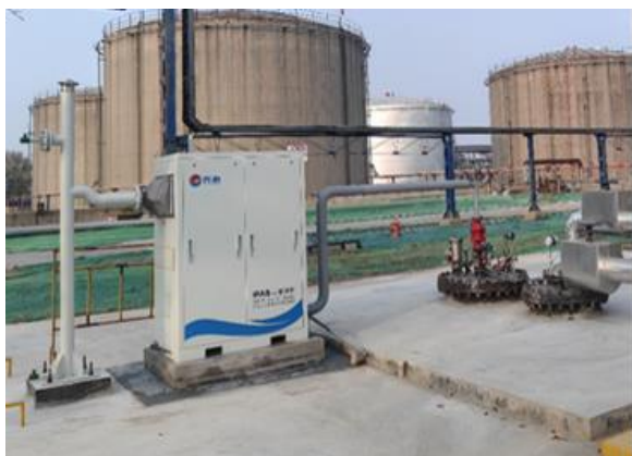
图 3.3 污水池废气无动力吸附设备
