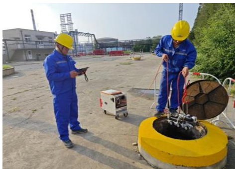
图 4 放置 CCTV 机器人
