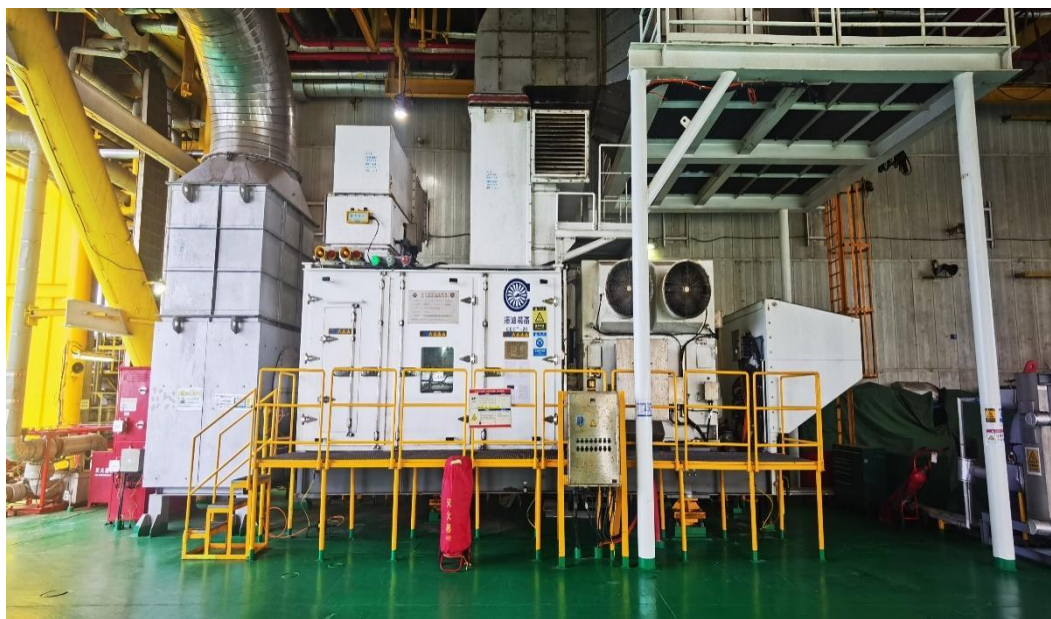
图 5 秦皇岛 32-6 微透平机组
