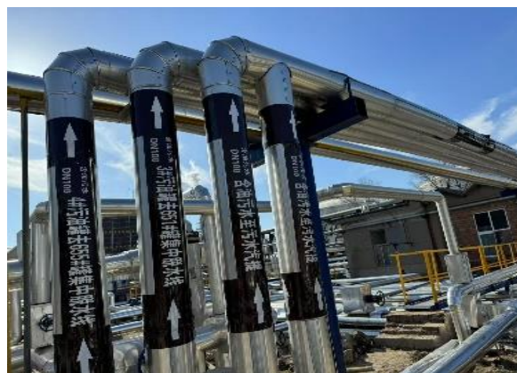
图 3.4 含油含硫污水分质输送处理
