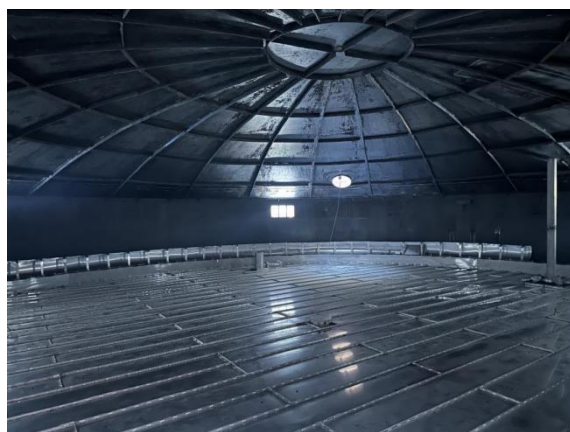
图5 储罐全接液浮盘和高效密封改造
