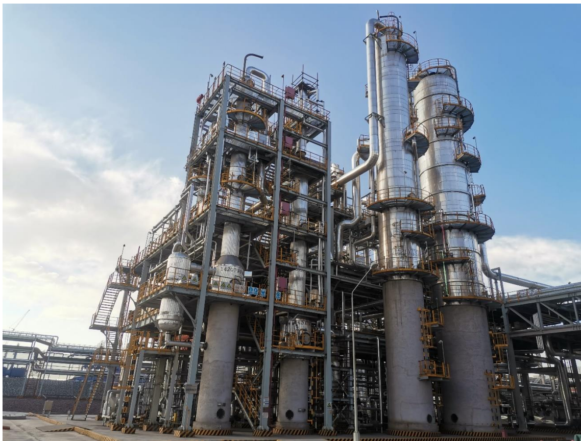
图 5 榆林化工首创水煤浆气化氨回收装置
