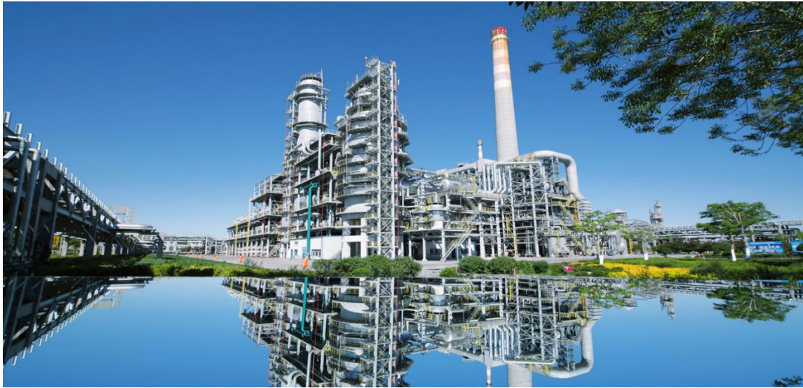
图 6 独山子石化 1000 万吨/年蒸馏装置
